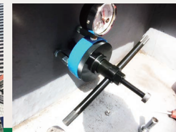
吊元アンカー引張試験
