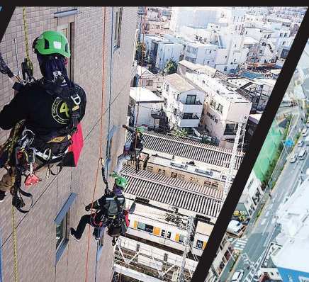
都内タワーマンション_打診調査
