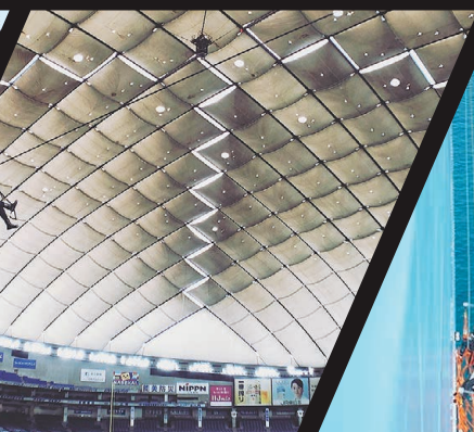
東京ドーム_バックネットワイヤー清掃
