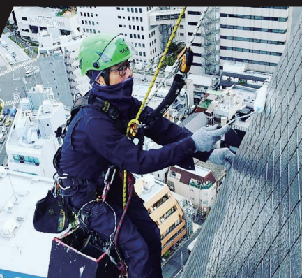
タワーマンション_漏水補修
