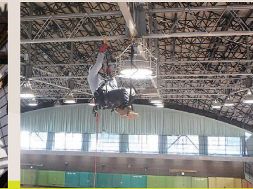
高天井照明交換
