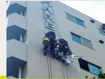
サイン撤去取付
