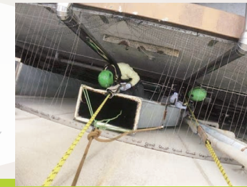
ダクト撤去・取付
