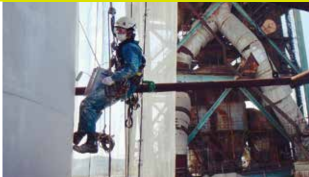
東ソーセメントプラント／サイロ塗装
