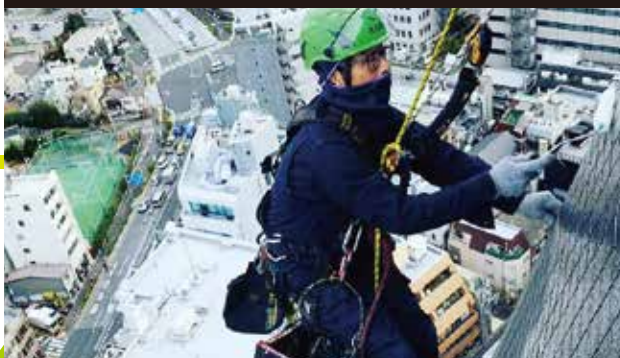
都内タワーマンション／漏水補修
