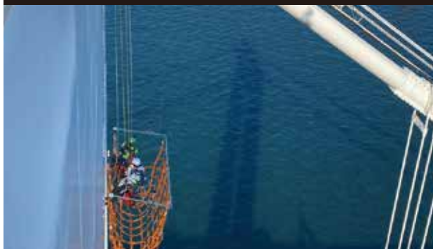
レインボーブリッジ／補修塗装工事
