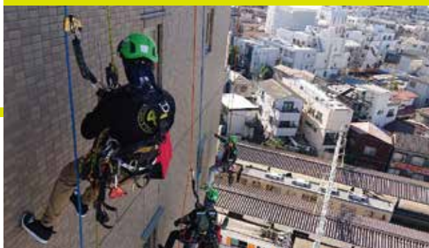
都内タワーマンション／打診調査
